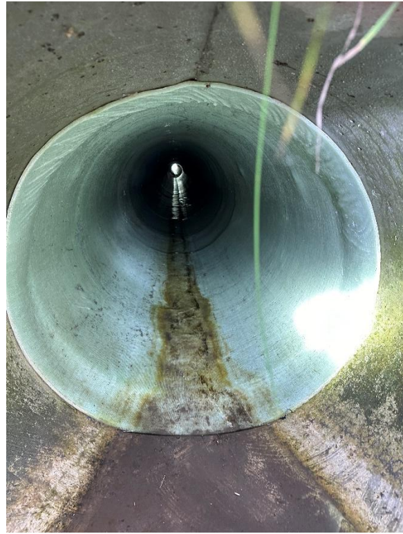
(d) Culvert 2184508, District 6: CIPP Liner
