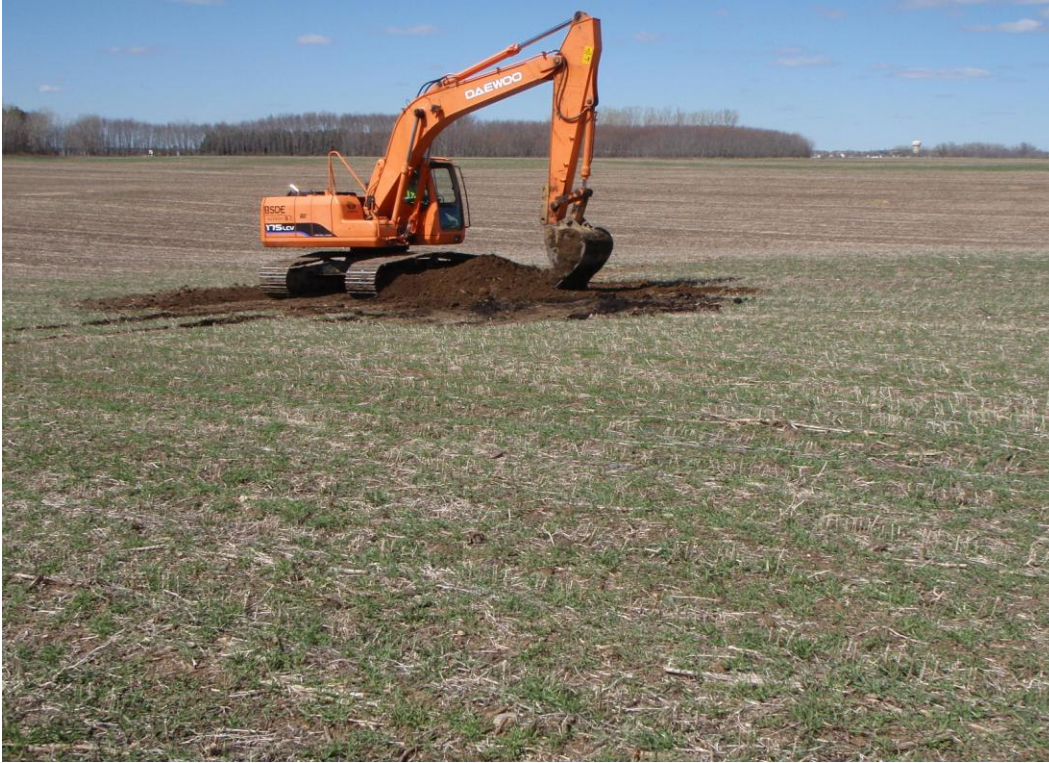
Excavator in the AUF.
