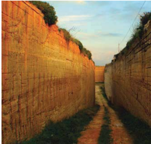
Fig. 5.1: Pedreres de s'Hostal.
