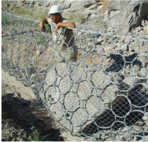
Fig. 6.3: Geobruigg Rockslide Barrier.
