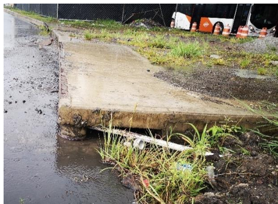
Figure 9 Pollution in Av Domingo Diaz
