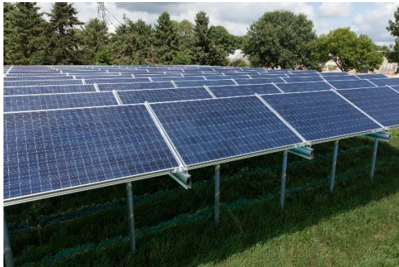
54 kW Solar PV
