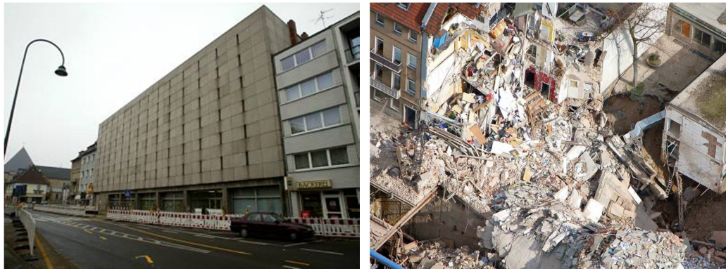
Abbildung 27-28, Das Historische Archiv Köln vor und nach dem Einsturz am 3.März 2009
