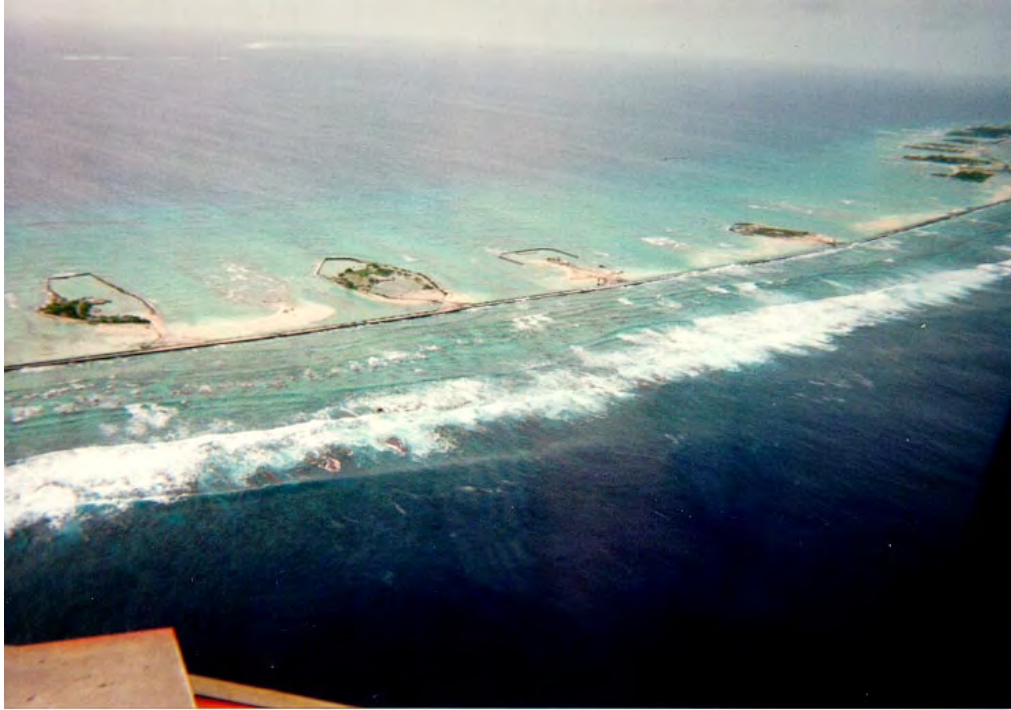
FIG. 1.13 Vue aérienne de la partie ouest de la zone d'essais 4 à Mururoa, prise en juillet 1996 (soit 16 ans après que les essais sur la couronne eurent cessé); la vue est prise de l'océan, en direction du lagon (remarquer que plusieurs sites d'essais et des zones affaissées à l'extrémité ouest de la zone d'essais 4 sont maintenant sous la mer; voir aussi Figure 2.23)
